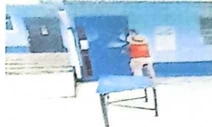
PINTADA DE PUERTAS DE LAS AULAS
